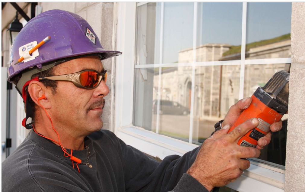
Plusieurs fenêtres à la Citadelle de Québec ont été remplacées lors des projets de restauration effectués en vue des festivités du 400 e anniversaire de la Ville de Québec.
